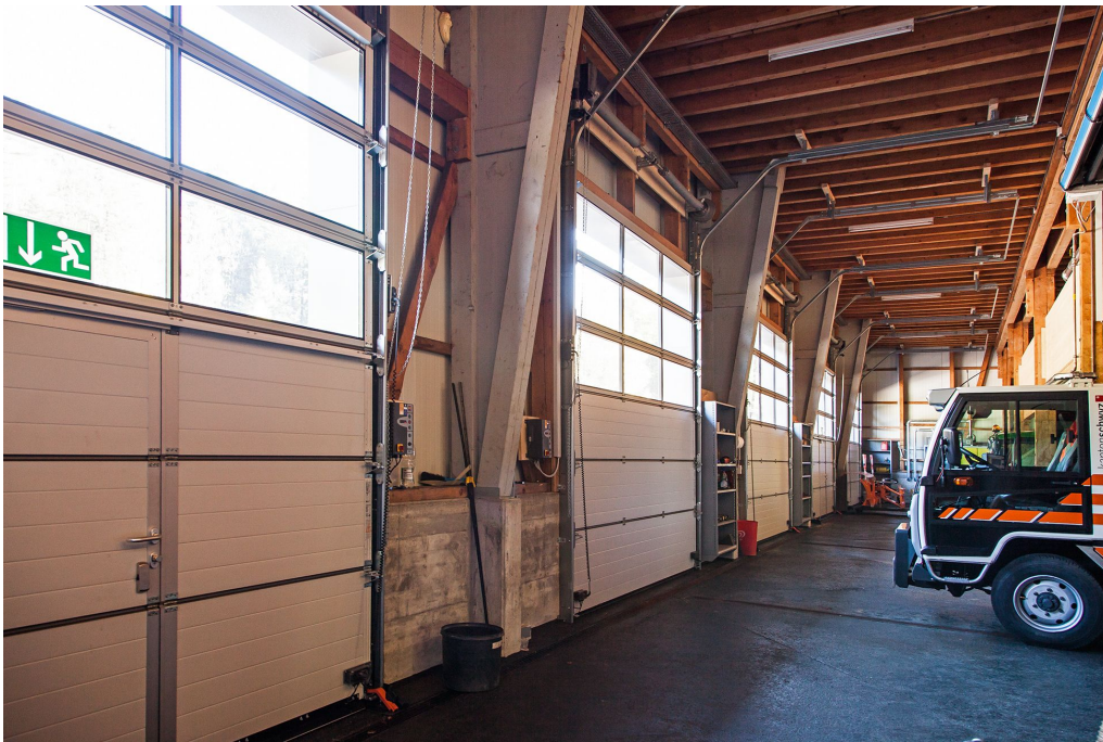
Industrie-Sectionaltor Innenansicht: Mit speziellen Rücklaufschienen
